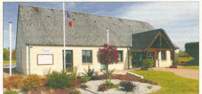
Le conseil municipal de la commune de Négreville a attribué les différentes délégations et commissions et a fixé les différentes indemnités.
