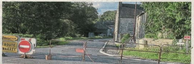
→ L'arrêt de circulation a été prolongé jusqu'au 18 septembre, la circulation ne sera pas possible sur cet axe pour la rentrée.
